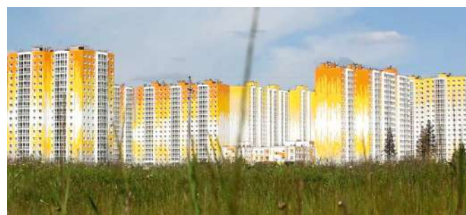
ЖК «Зеленоградский», г. Солнечногорск
